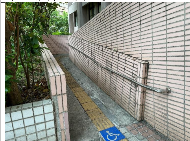
明道樓前方無障礙坡道第一段區域。
