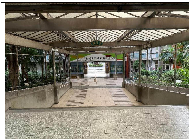
明道樓川堂通往忠勤樓無障礙坡道興建完成約30年。
